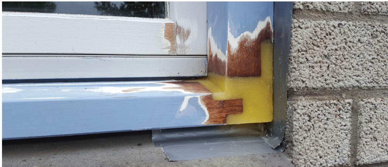
Reparatie met de DRY FLEX™
